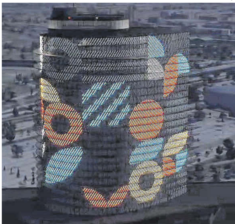
Así será la Torre del Agua de Zaragoza cuando finalicen las obras.
